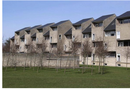
Alléhusene på Jægersborg Allé (th)
