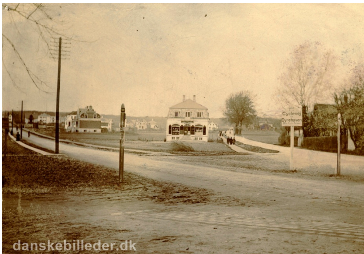
Figur 28a. Vilvordevej fra Femvejen cirka 1905, bemærk "Cyclevej til Dyrehaven"
